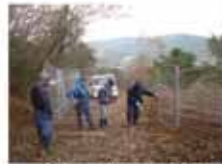
【防護柵の設置作業】
