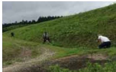
【法面の草刈作業】
