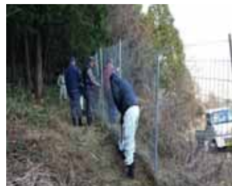
【獣害防止柵の設置】
