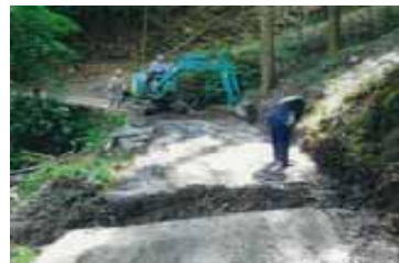
【道路整備作業の様子】
