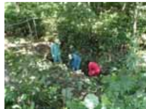
【排水路清掃作業】
