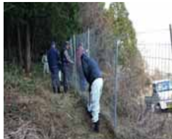
【獣害防止柵の設置】
