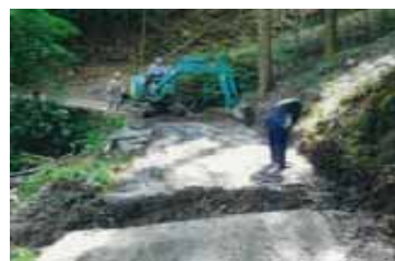
【道路整備作業の様子】
