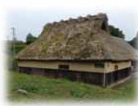
【笹葺き屋根の家】
