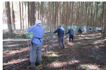
【鳥獣害侵入防止柵設置作業】
