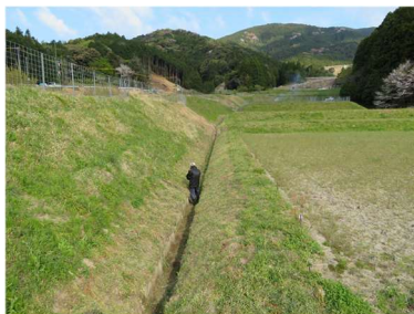
【片山地内の取組箇所】
