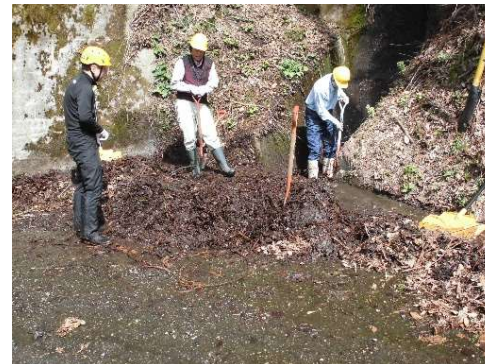
【水路補修の様子】
