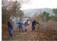
【防護柵の設置作業】
