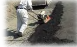
【舗装作業の様子】
