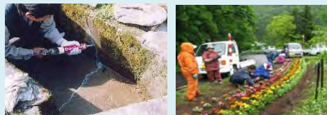
水路のひび割れ補修
