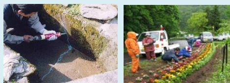
水路のひび割れ補修
