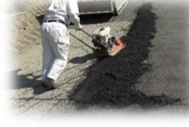
【舗装作業の様子】
