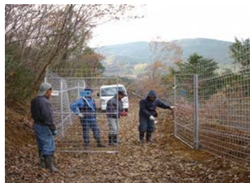
【防護柵の設置作業】
