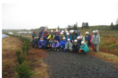
【植樹作業(排水路周辺)】
