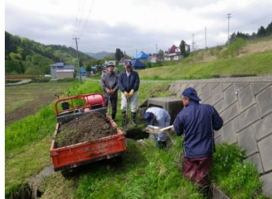
【共同作業(水路の泥上げ)】
