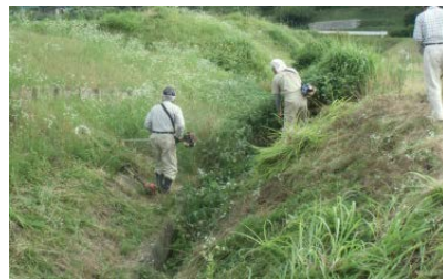
【排水路の草刈り】
