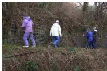
【獣害防止柵の設置】
