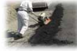
【舗装作業の様子】
