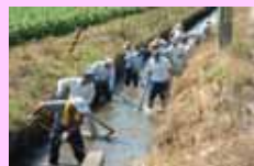
水路の泥上げ
