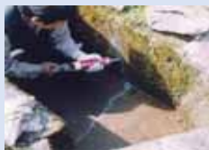
水路のひび割れ補修
