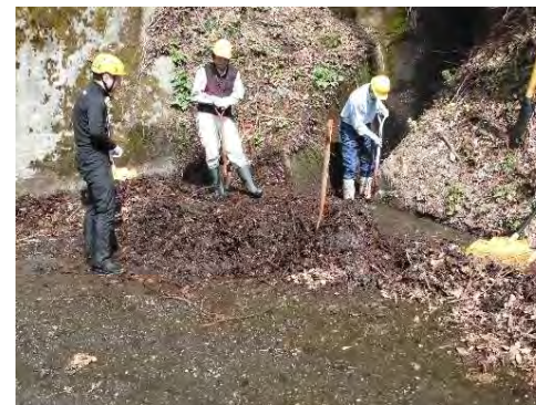
【水路補修の様子】
