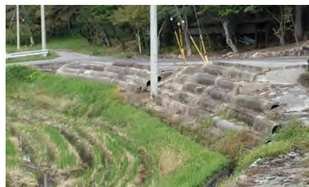
【U字溝で固めた法面】
