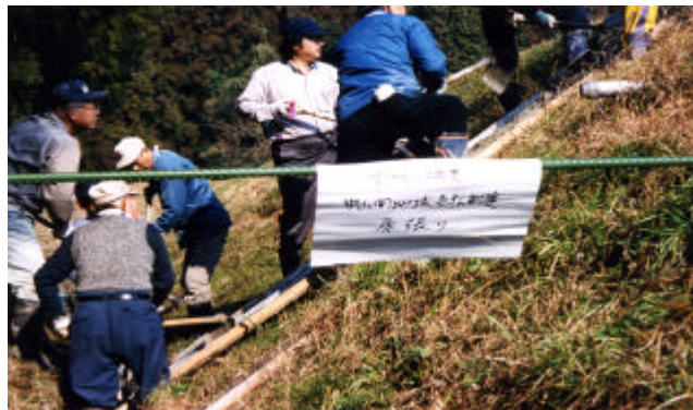
床張り（生コン打ち）
