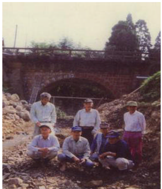
清掃された石橋と河川
