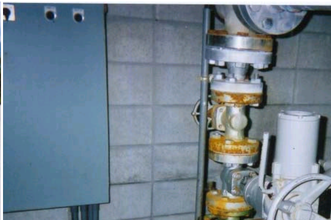
共同管理しているポンプ施設
