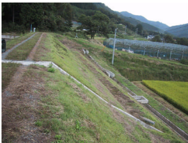
適切な管理がなされている台新池の堤体
