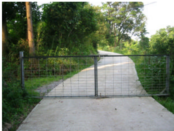
集落入口の道路にも防護柵設置（開閉式）
