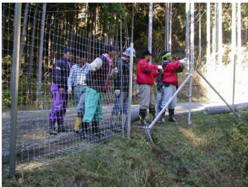
総合鳥獣防止柵の設置
