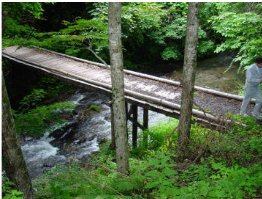
木材を持ち寄り自力で架け替えた橋梁
