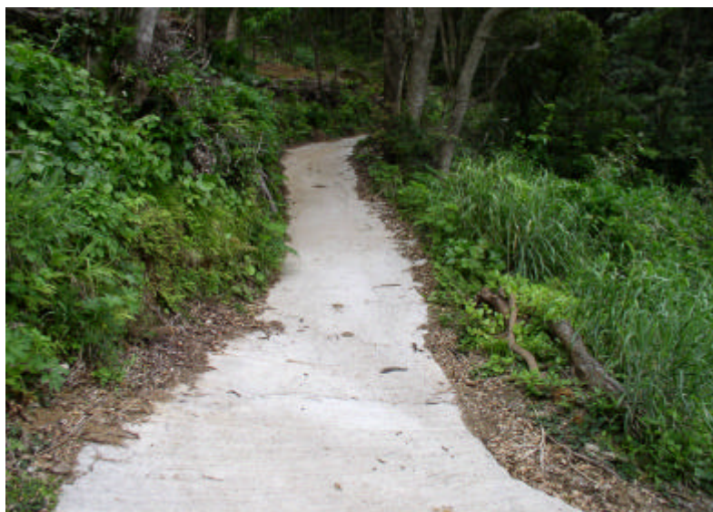
道路の整備状況
