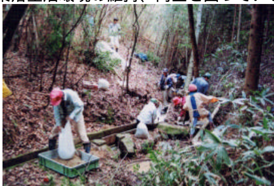
農業用水路の改修
