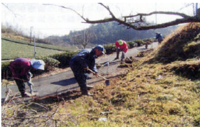
農道管理作業風景
