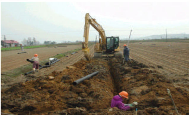
暗渠排水工事
