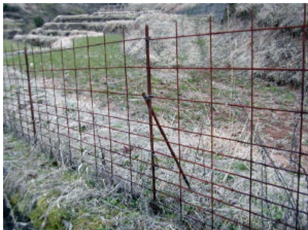
防護柵の設置状況
