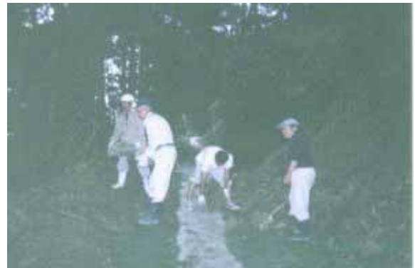
②農道管理作業（落石除去）
