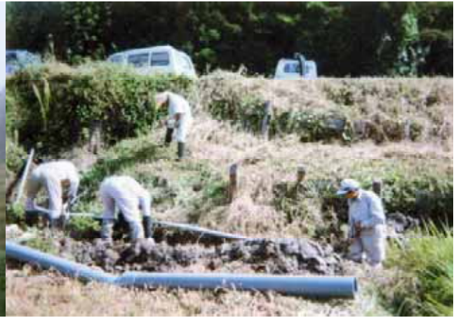
＜水路の補修作業の様子＞
