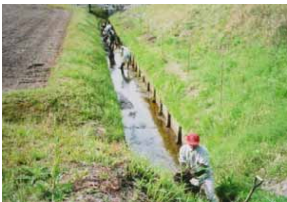
用水路の整備
