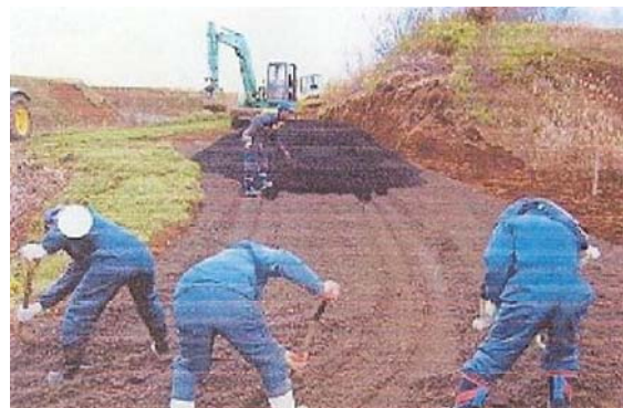
農道の補修作業（砂利敷設等）
