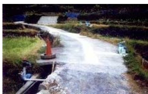
パイプライン整備工事
