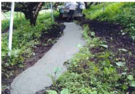
果樹棚の補強、園内道路の補修・補強
