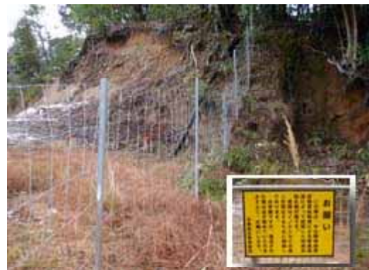
猪防護フェンス
