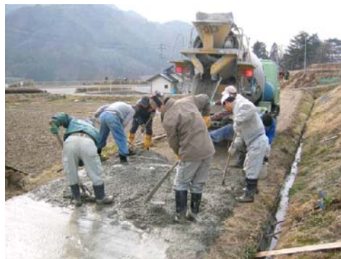
農道のコンクリート舗装
