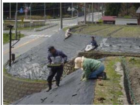
除草シート及び景観植物植え付け
