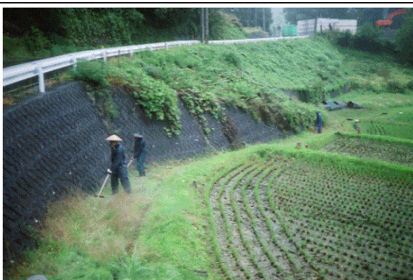
水路周辺の草刈り
