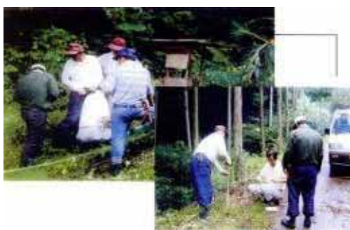
電気柵の線の張り替えと器具の設置作業
