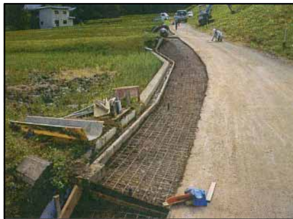
農道の補修工事
