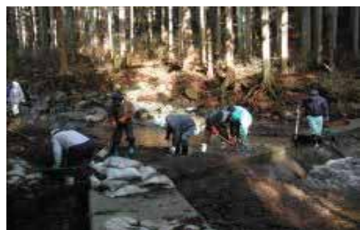
老朽化した取水堰の補修
