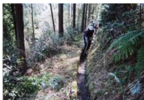
水路除草作業
