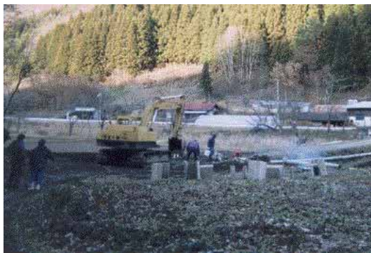
水路改修工事
