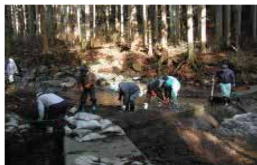
老朽化した取水堰の補修
