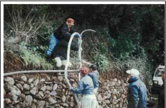
農業用水ホースの交換、石垣の整備
