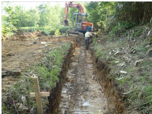
【用水路掘削作業】
