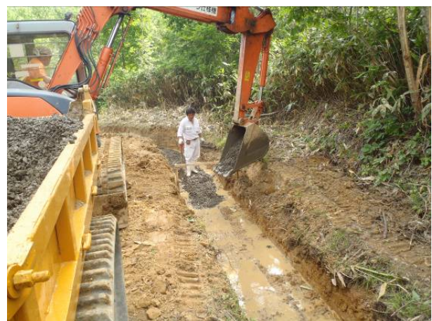
【用水路砂利敷き作業】
