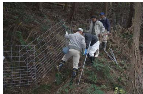
【ワイヤーメッシュ柵の設置】
