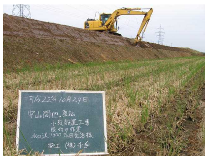
【高畦に作業用の小段を設置】
