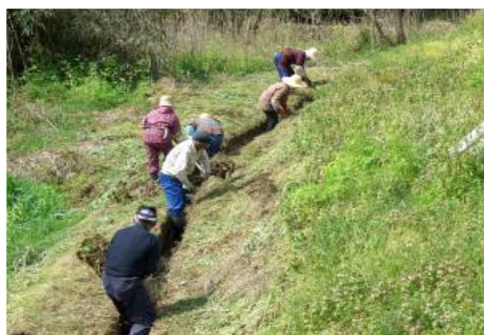
【農道・水路共同作業の様子】
