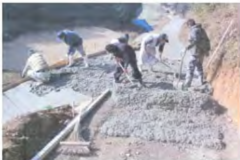
【農道の舗装作業】
