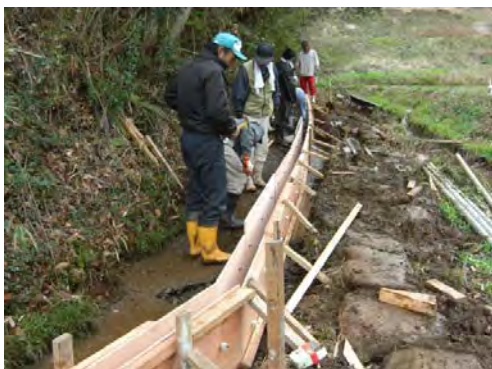
【漏水整備作業中】
