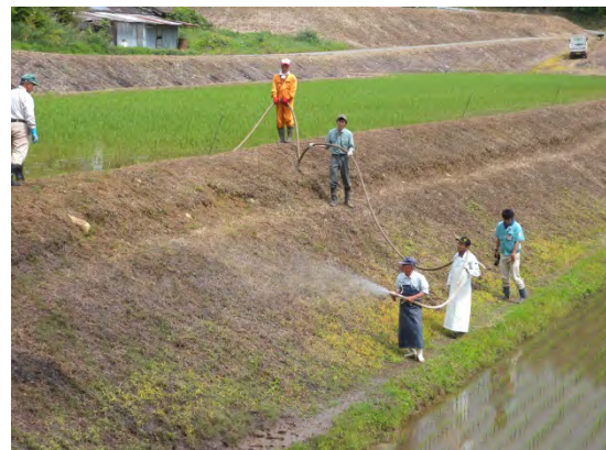
【吹付作業の様子】
