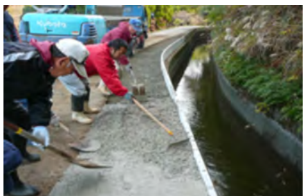
【集落での水路・農道整備の様子】
