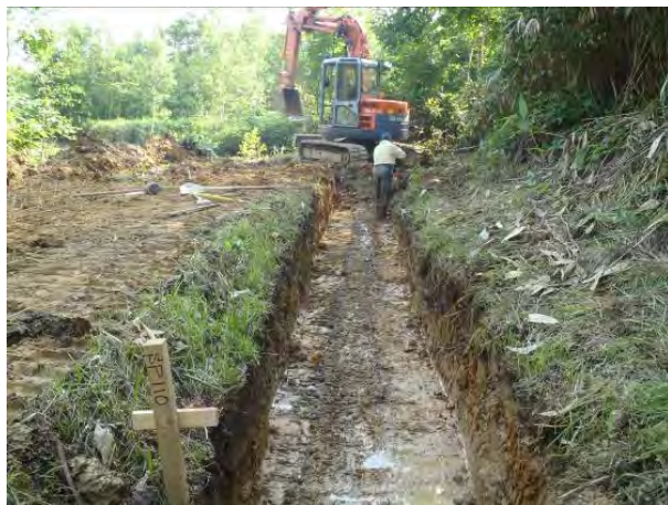
【用水路掘削作業】
