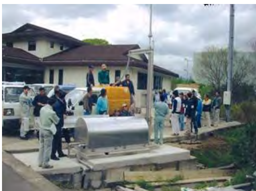
【給水施設の整備】
