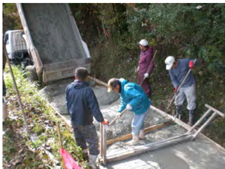
【農道舗装自己施工】
