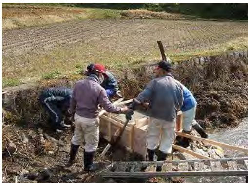
【頭取工の修繕】
