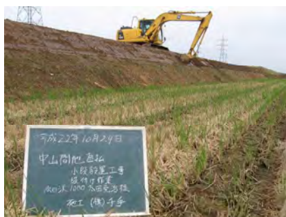
【高畦に作業用の小段を設置】
