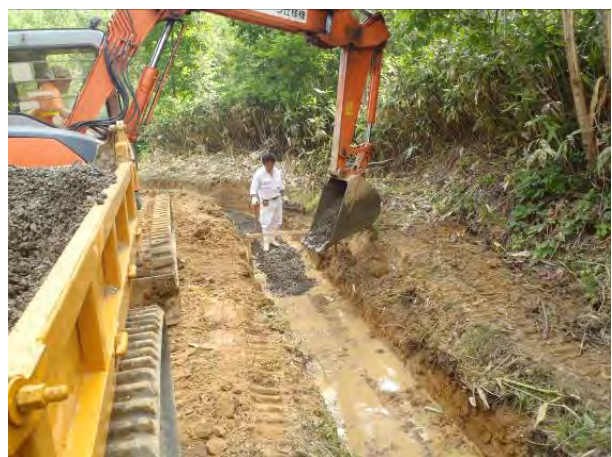
【用水路砂利敷き作業】
