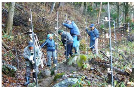
【電気柵設置状況】
