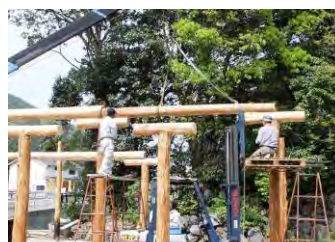
【共同作業場・建設中】
