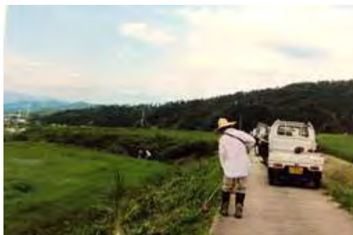
【直営で舗装された農道と法面草刈】
