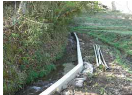
【漏水整備完成】
