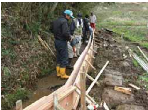
【漏水整備作業中】
