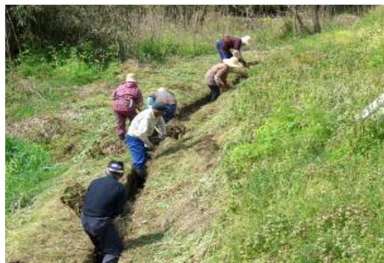
【農道・水路共同作業の様子】
