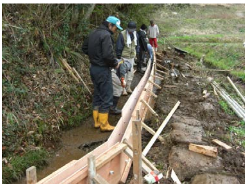
【漏水整備作業中】
