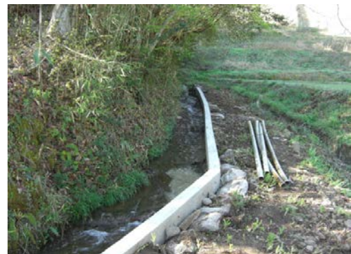
【漏水整備完成】
