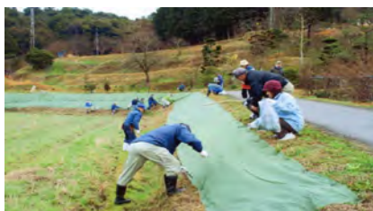
【防草ネットの設置作業】
