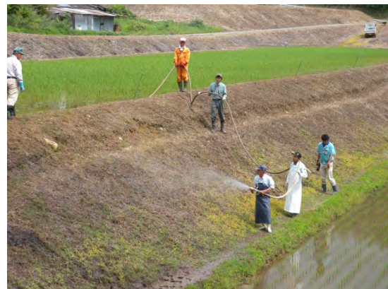
【吹付作業の様子】
