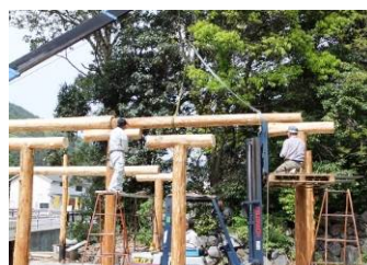
【共同作業場・建設中】
