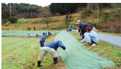
【防草ネットの設置作業】
