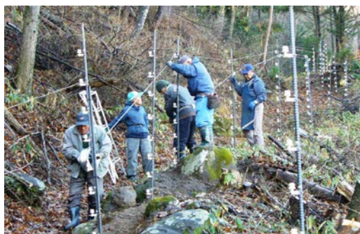
【電気柵設置状況】
