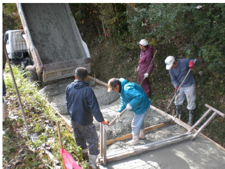
【農道舗装自己施工】
