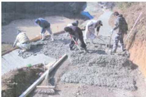
【農道の舗装作業】
