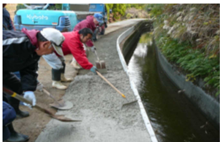
【集落での水路・農道整備の様子】
