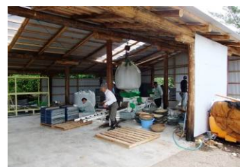
【共同作業場・完成】
