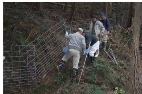
【ワイヤーメッシュ柵の設置】
