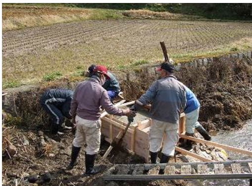
【頭取工の修繕】
