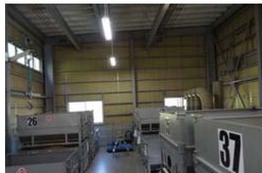
【大豆・米乾燥調整施設】
