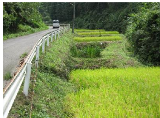
【電気柵の設置状況】
