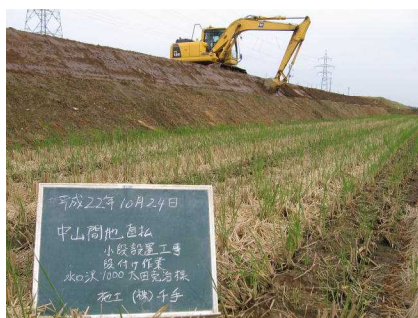
【高畦に作業用の小段を設置】
