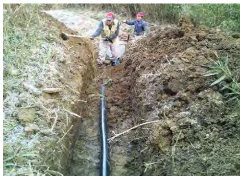
【自己施工によるパイプライン敷設】
