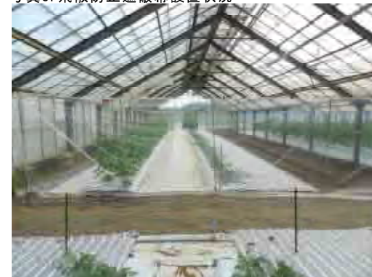
写真3. 飛散防止遮蔽幕設置状況
