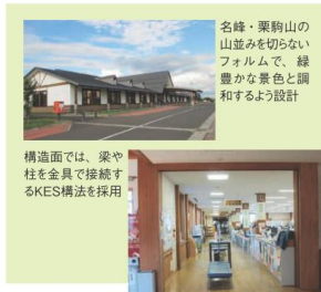
木造2階建ての北分署。主要構造部の柱および梁には集成材や耐火性を強化
