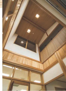
主要構造は鉄骨ながらも、随所に木材を使用した東分署のエントランス
