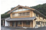
木造2階建ての北分署。主要構造部の柱および梁には集成材を使用し、耐火性や耐震性を強化
