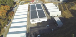
工場は震災前の2倍以上の規模に増設。菌床の培養施設、しいたけの発生室のほか、物流をスムーズにするための保管庫を建設した
