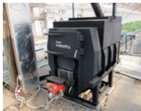
薪ストーブで灯油の暖房機並みの保温効果が得られた。「薪を自己調達できるならコストをかなり削減できます」(川村さん)
