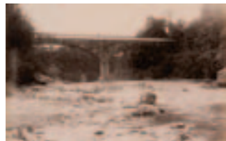
志染川 (しじみがわ) の谷に淡山疏水の水を渡すため、1891年に設置。
