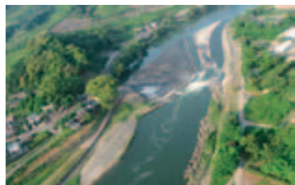
現在の山田堰の全景。
