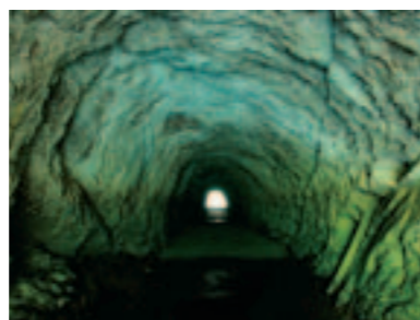
素掘り隧道 (ずいどう) の柳谷 (やなぎたに) のトンネル。
