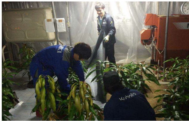
マンゴーの栽培ハウス内で防草シートを敷設している様子。
